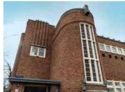
De renovatie was een flinke klus.
