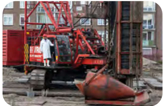
De eerste paal van de nieuwe school
