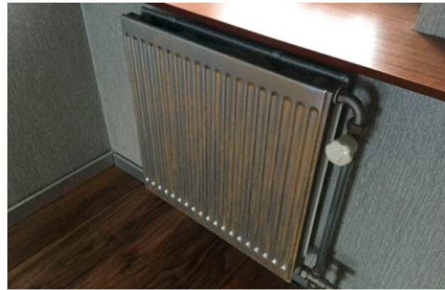
Geschilderde radiatoren zijn alleen toegestaan met witte radiatorenlak. Zijn er vanuit de bouw donker gekleurde radiatoren of leidingen geplaatst, dan zijn deze wel toegestaan.
