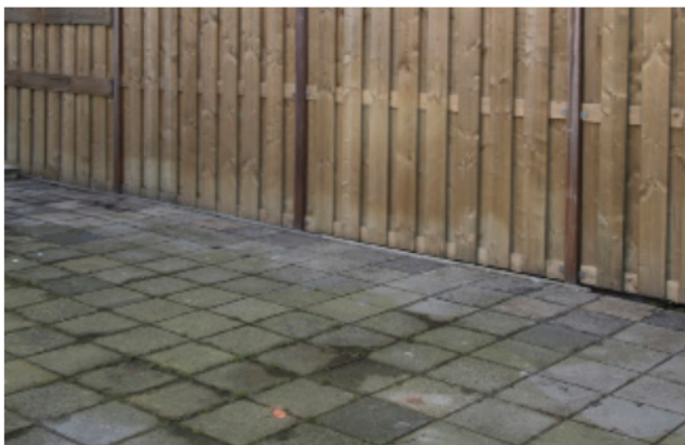
Verkleuringen in tegels
