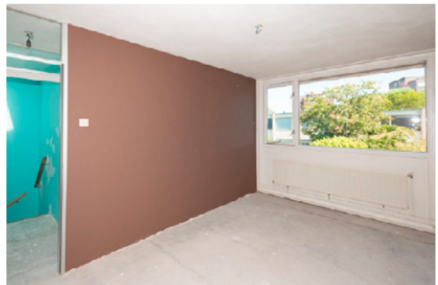
De wand moet na 2x schilderen een dekkend resultaat hebben
