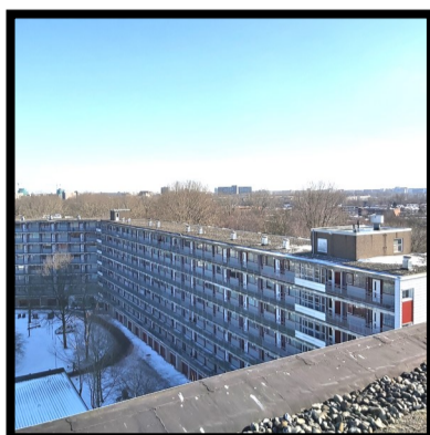
isolatie dak verbeteren vervangen dakbedekking en mv-units (onderhoud)
