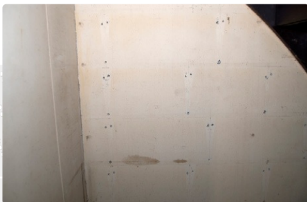
Boorgaten in de muur
