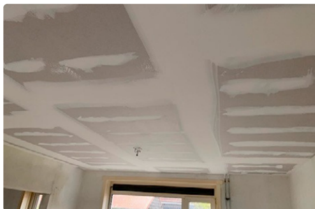
Nieuwe gipsplaten zijn dichtgesmeerd en in 2 handelingen is een dekkend resultaat te krijgen
