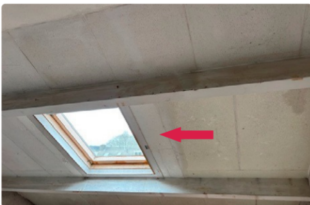
Zelfaangebrachte isolatie (In dit geval Tempex)
