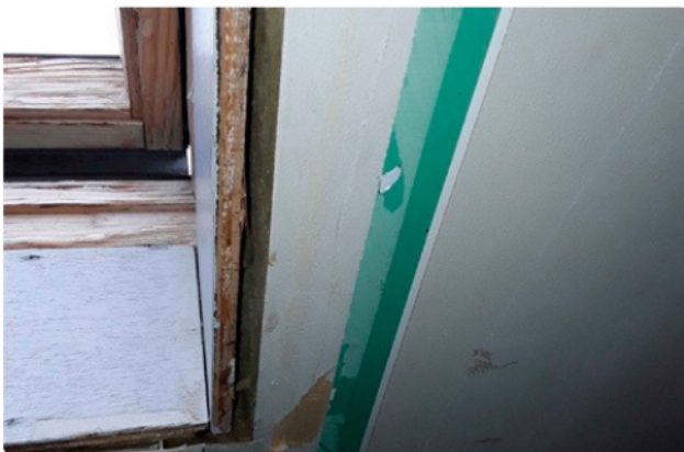
Dakraam betimmering herstellen
