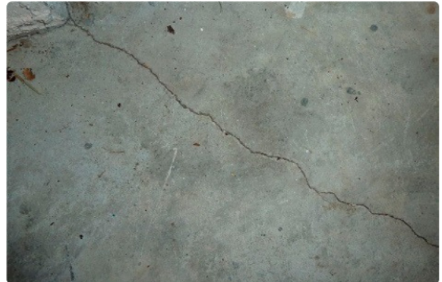
Krimpscheurtjes in vloer (<3 mm)
