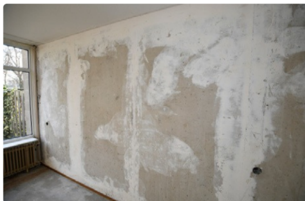
Betonnen wand (Behangklaar)
