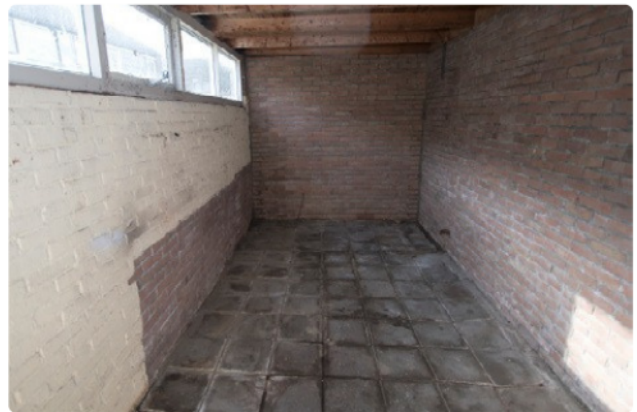
Kleurverschil in stenen
