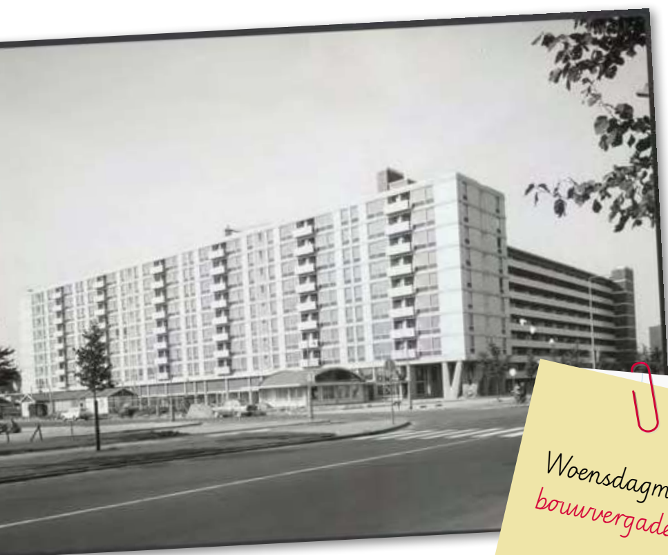
Het Rivierenhuis is bijna klaar. De bouwkeet staat er nog.
