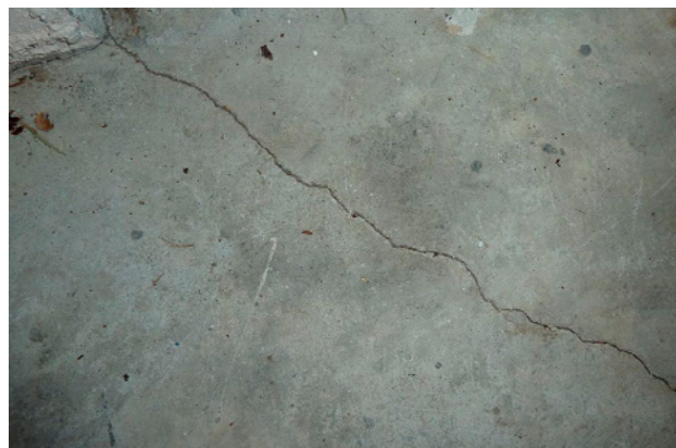
Krimpscheurtjes in vloer (<3 mm)
