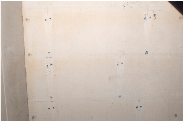
Boorgaten in de muur
