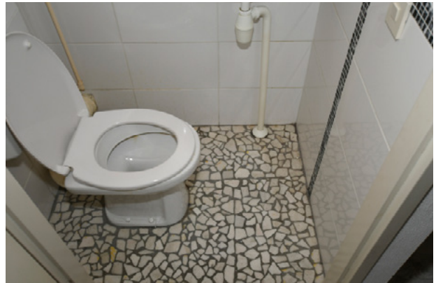
Tegelwerk niet standaard
