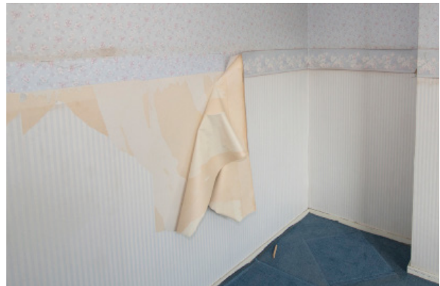
Behang laat los (klein stukje/hoekje te plakken behang kan/mag loszitten)
