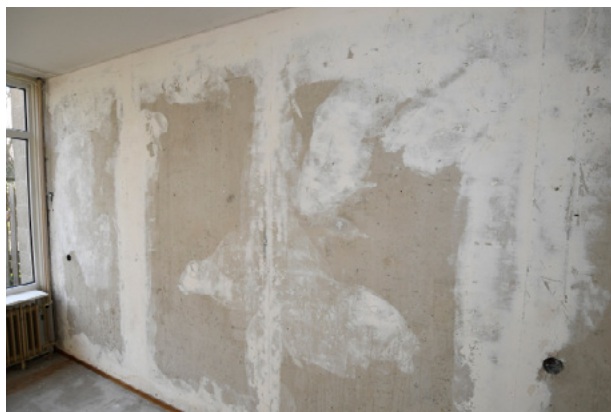
Betonnen wand (kleine luchtbellens kunnen aanwezig zijn)
