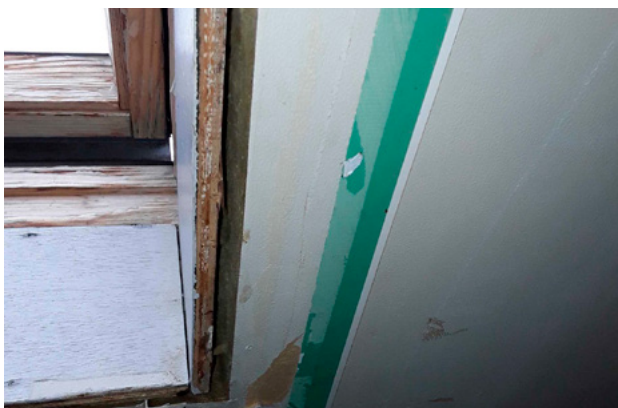
Dakraam betimmering herstellen
