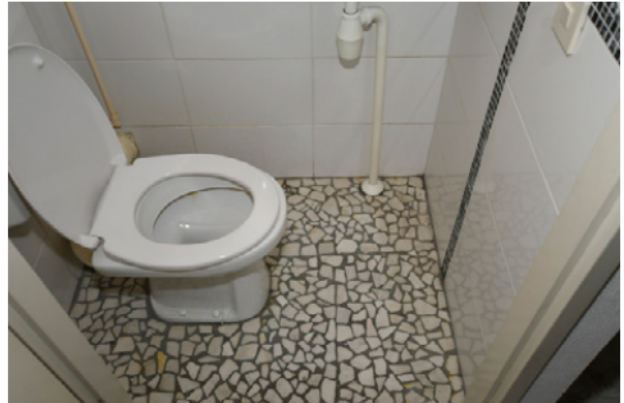
Tegelwerk niet standaard
