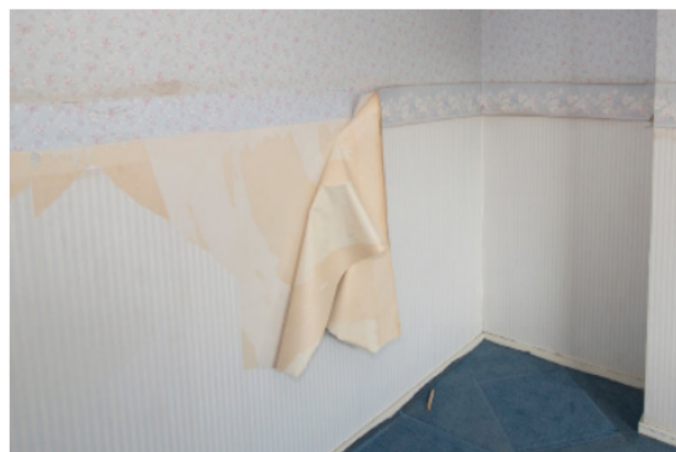
Behang laat los (klein stukje/hoekje te plakken behang kan/mag loszitten)
