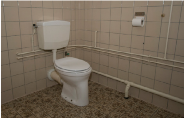
Toilet in goede staat
