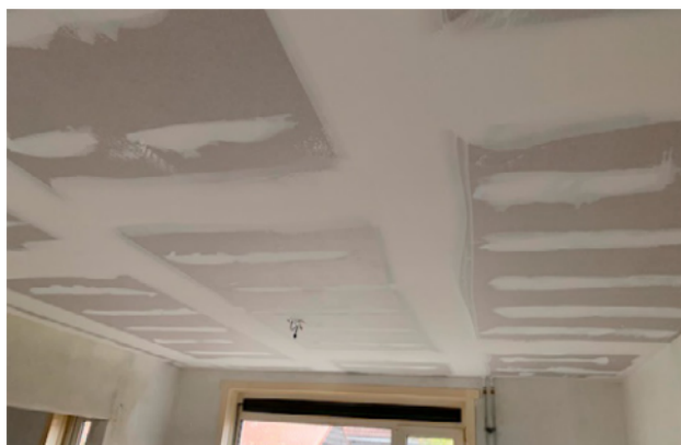
Nieuwe gipsplaten zijn dichtgesmeerd en schilderklaar
