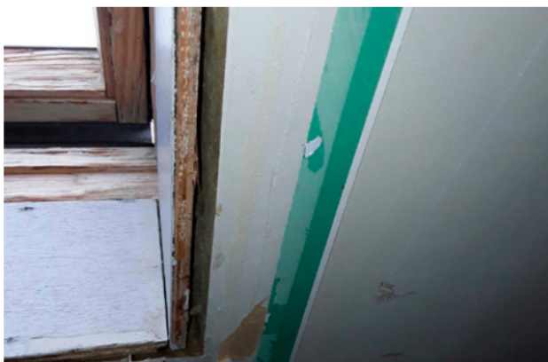
Dakraam betimmering herstellen
