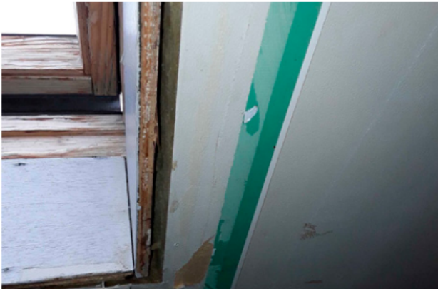
Dakraam betimmering herstellen
