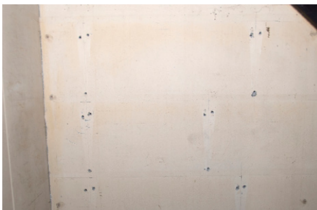
Boorgaten in de muur
