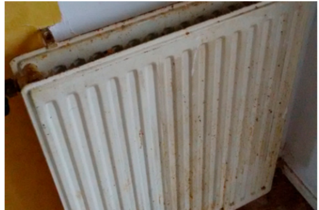
Aanslag en roest (niet meer te herstellen)
