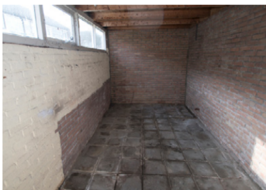
Kleurverschil in stenen
