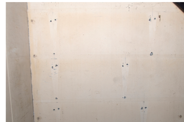
Boorgaten in de muur
