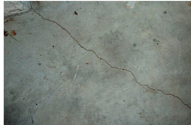
Krimpscheurtjes in vloer (<math>\leq 3\text{ mm}</math>)
