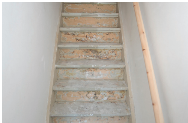
Trap met minimale lijmresten
