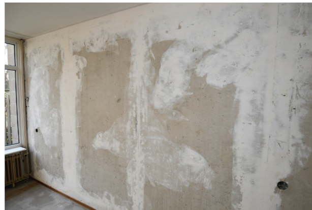
Betonnen wand (kleine luchtbellens kunnen aanwezig zijn)
